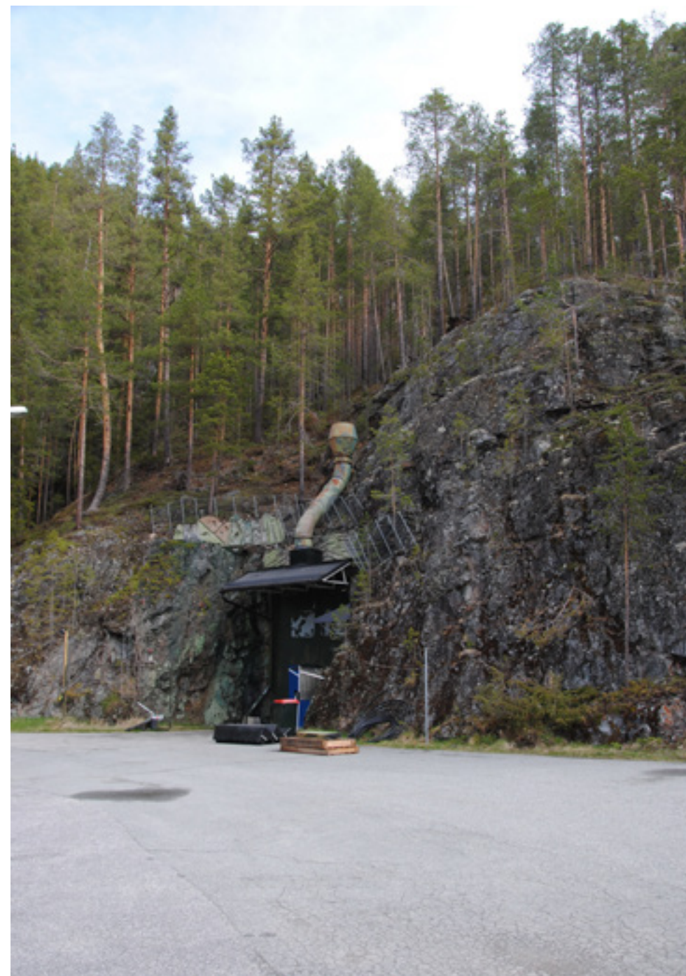
Ett av inslagen till en av landets största berganläggningar för militärområdestygmaterielförråd. Det innehöll både förråds- och verkstadsanläggning för hela militärområdet. Ett av rikets tre bergtryckerier fanns också här. Foto Sten Ekman
