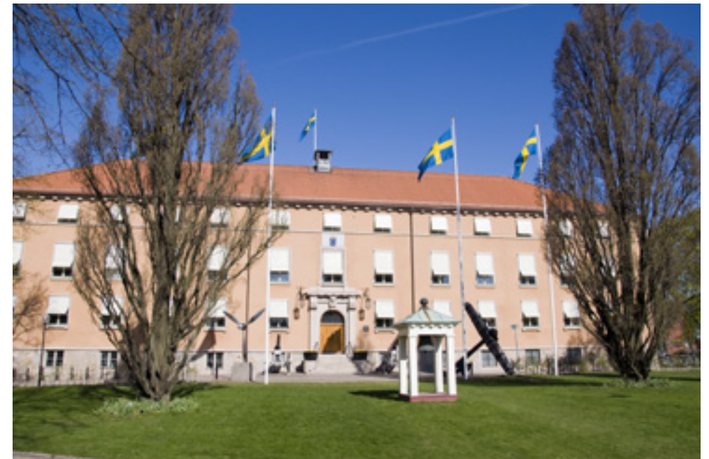
Försvarshögskolan, i vilken även ingår den tidigare Militärhögskolan, flyttade 2005 till nybyggda lokaler på Campus Kungliga Tekniska Högskolan, vilka anslöts till denna byggnad som ursprungligen byggts för Statens provningsanstalt på 1920-talet. Foto Försvarshögskolan
