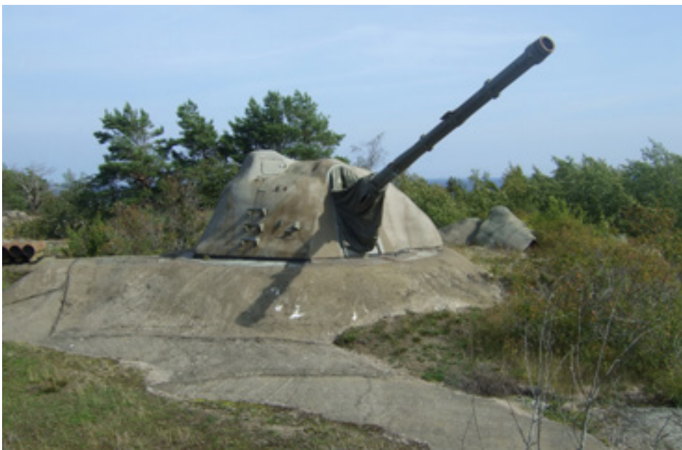
Kustartilleriet tillfördes 1977 - 1983 sex 12/70-batterier, grupperade från Skåne till Holmögadd. I varje batteri ingick tre helautomatiska pjäser. Alla enheter i batterierna hade hög skyddsnivå. Denna pjäs ingick i Batteri Landsort och visas för allmänheten. Foto Sten Munck af Rosenschöld
